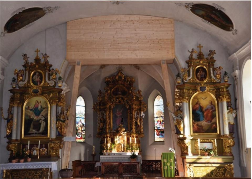
**Kircheninnenraum mit abgestütztem Chorbogen wartet auf Instandsetzung**
