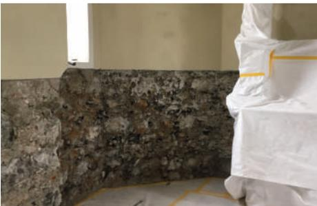
**Bild unten und Mitte: Durchfeuchtungsschäden im Innen- und Außenbereich** Fotos: W. Walser
