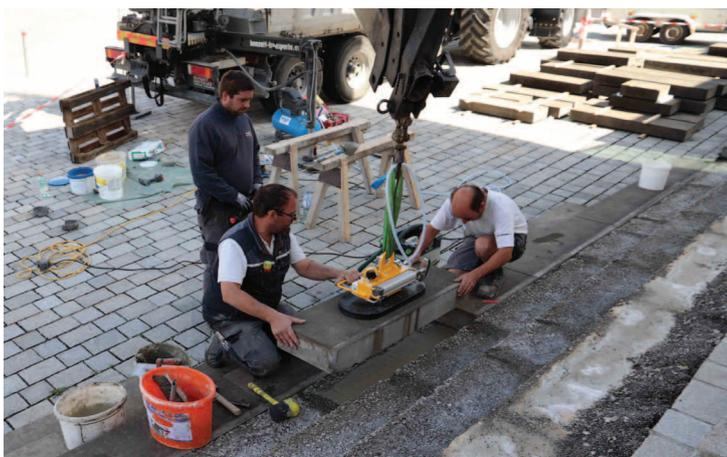
Aufgrund von Frost- und Wasserschäden war es notwendig die Außentreppe unserer Pfarrkirche zu sanieren. Auf dem Bild sehen Sie, wie eine 300 kg schwere Treppenstufe neu versetzt wird.
