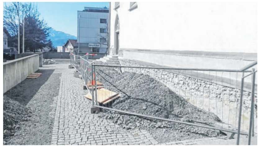
Bei der und rund um die Pfarrkirche Weiler haben vor wenigen Tagen die Sanierungsarbeiten begonnen. MÄSER
