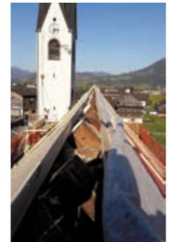
**Kirchendachsanierung in Schwarzenberg.** Rechts oben: Die Hälfte der alten Sparren war morsch und musste ausgetauscht werden. Unten (v.l.): Das alte Kupferdach wird weggebracht; die alten Balken werden abtransportiert; der Glockenstuhl vom „Totenglöggele“ ist morsch und wird zur Restaurierung weggebracht; auf der Dachspitze ist Präzisionsarbeit angesagt. PFARRE SCHWARZENBERG
