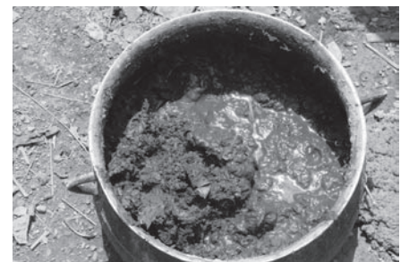
Topf mit Lehm zum Verputzen der Hütten
