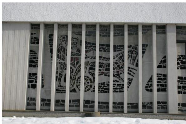
Nach dem Transport werden die einzelnen Platten vor Ort zusammengesetzt, in die offenen Wandprofile eingesetzt.
