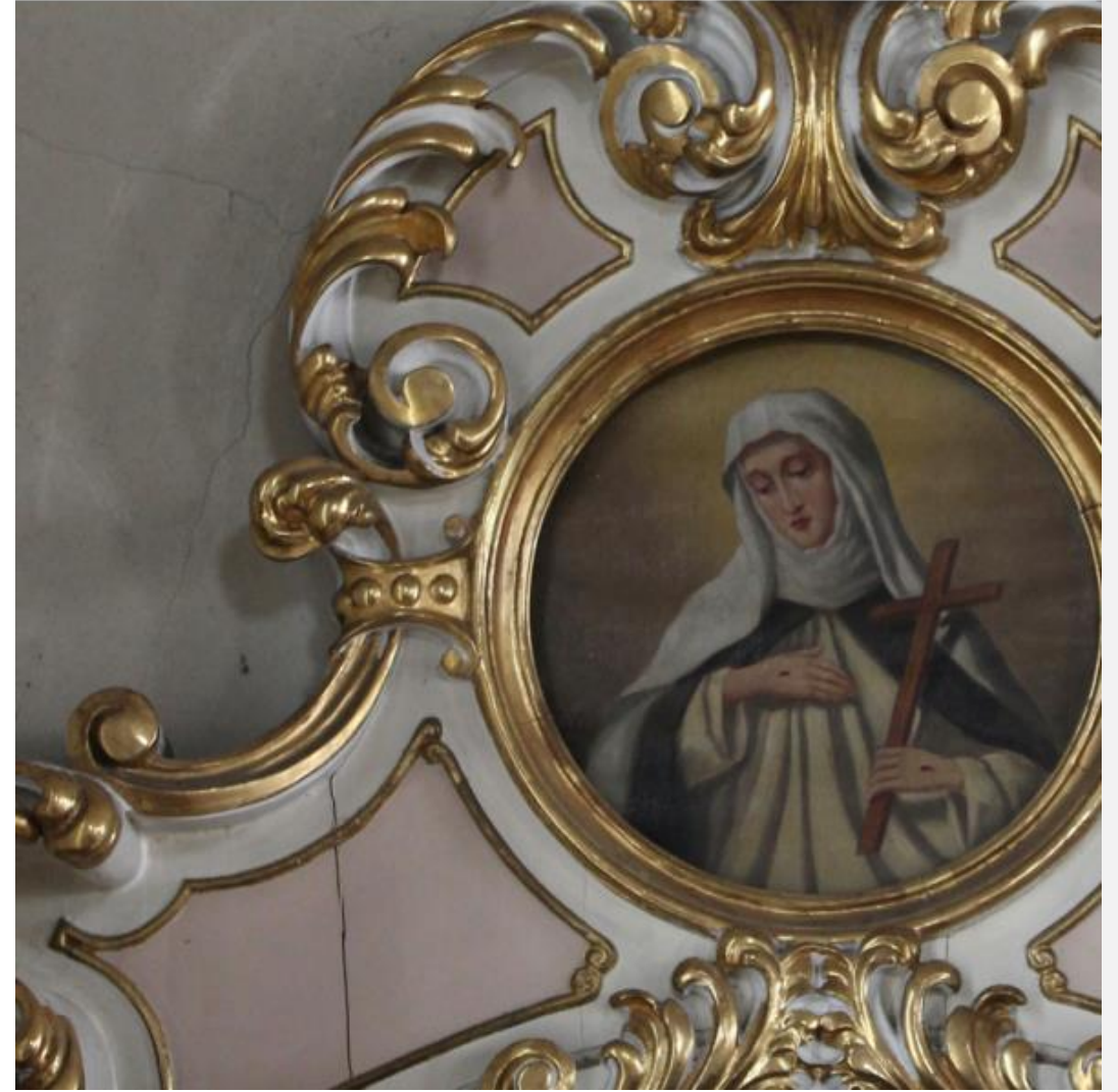
Schwundriss auf Grund Klimaschwankungen
