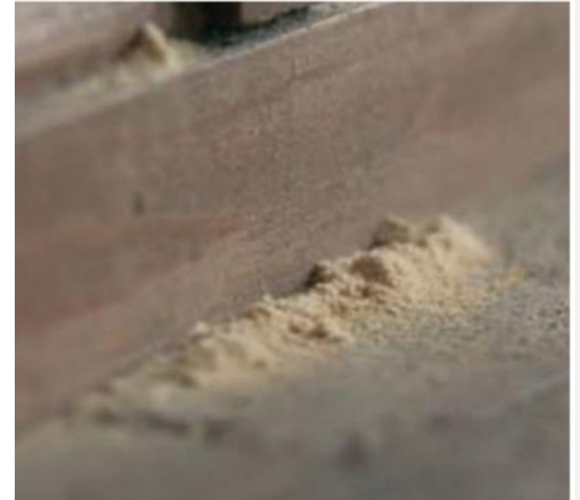
Bohrmehlhaufen weisen auf akuten Schädlingsbefall hin
