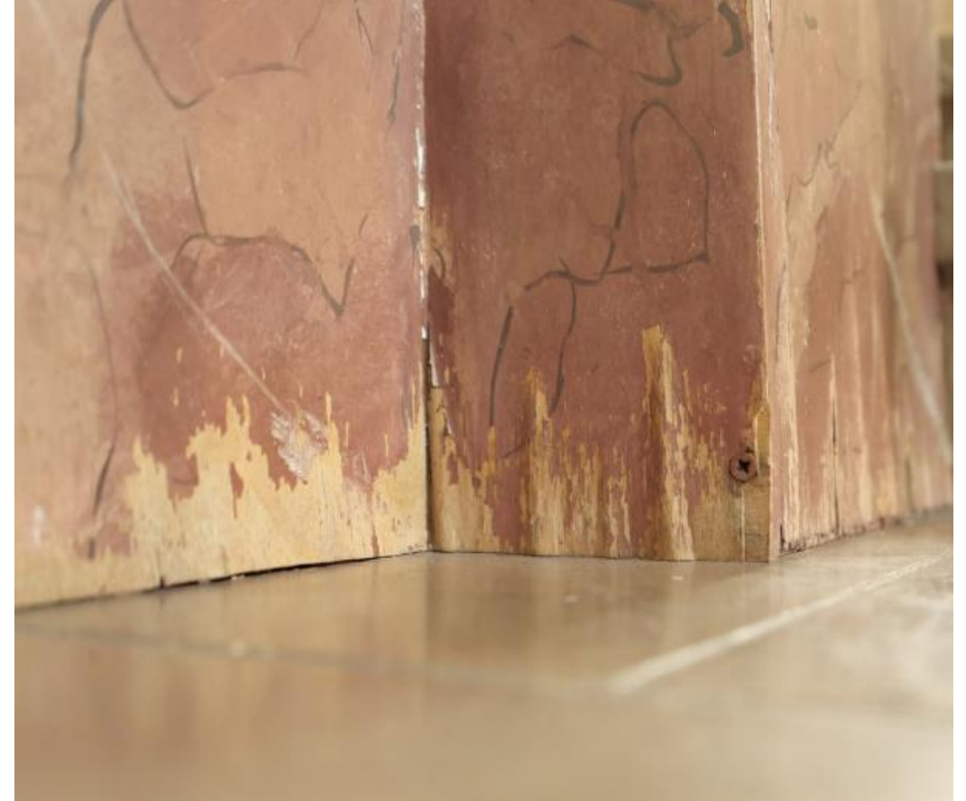
Quellspuren im Sockelbereich bei zu intensivem Bodenreinigen
