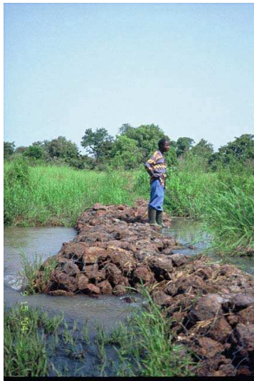
Die gebauten Dämme halten am Ende der Regenzeit (September/Oktober) das Regenwasser für die Brunnen zurück.
